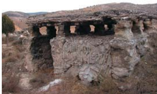
Horno de yeso en Navarrete
