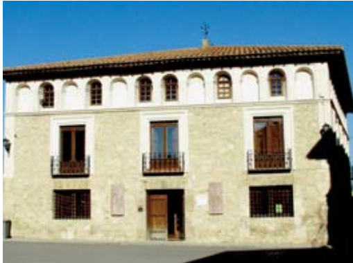
Casa Solariega de los Gonzalo de Liria de Monreal del Campo. Actual Casa de Cultura
