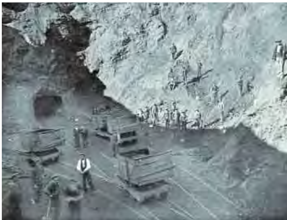
Compañía Minera de Sierra Menera. Mina Pilarica. Cantera nº 9 (hacia el año 1911)
